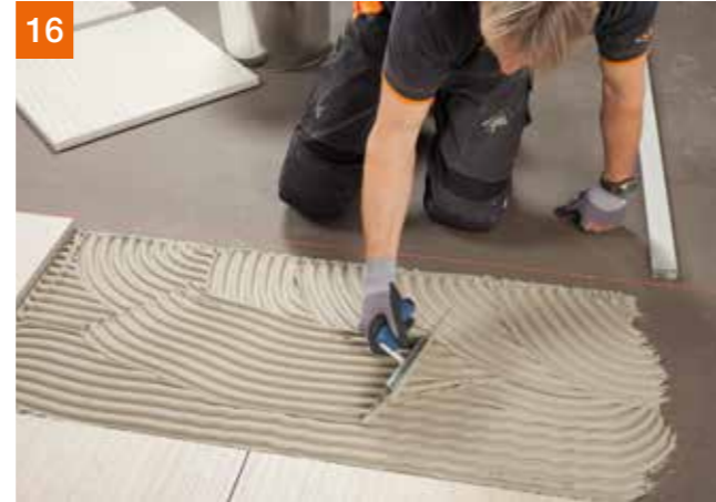
16 Aufziehen des PCI Flexmörtel® S2 mittels Mittelbettkelle
