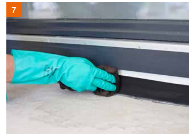
7 Reinigen des Untergrundes mit PCI Univerdüner
