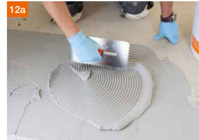
a. Aufkämmen von PCI Seccoral® 2K Rapid mit einer 6 mm Zahnung
