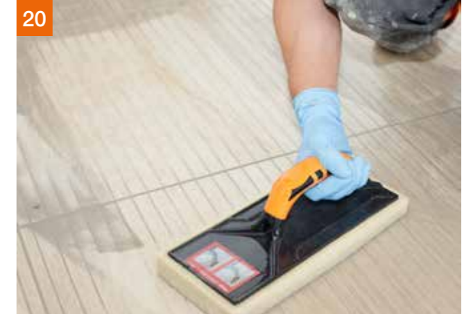
20 Waschen des Fliesenbelags
