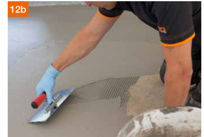
b. Glattziehen von PCI Seccoral® 2K Rapid
