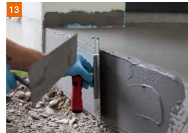
Abspachteln der Stirnseite mit PCI Seccoral® 2K Rapid (bei Balkonen bis zur Tropfkante)
