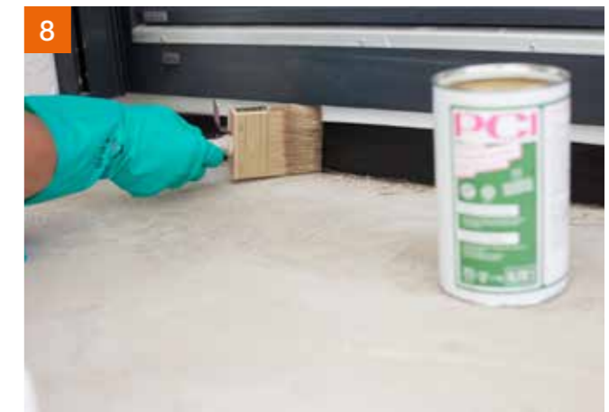
8 Grundieren des Untergrundes mit der entsprechenden Grundierung, siehe Tabelle
