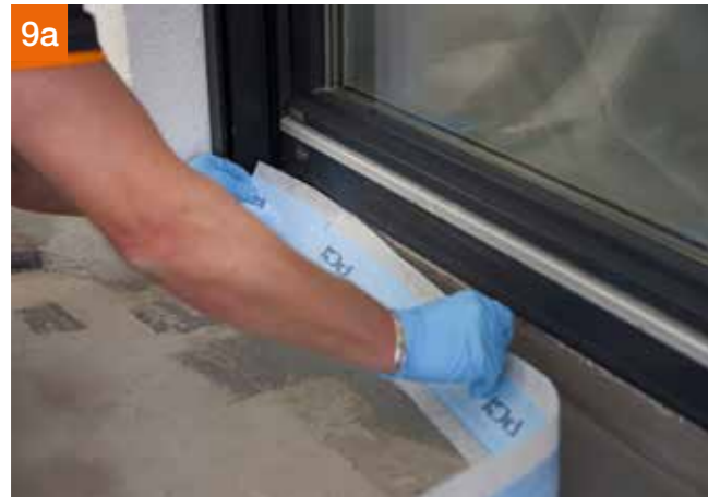
Das Dichtband PCI Pecitape® 120 mittels PCI Seccoral® 2K Rapid ankleben
