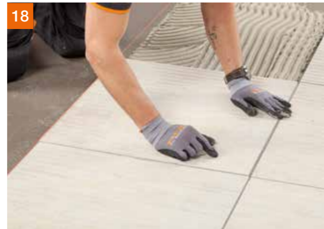
18 Einlegen der Fliesen unter mehrmaligem Hin- und Herschieben bei gleichzeitigem kräftigem Drücken
