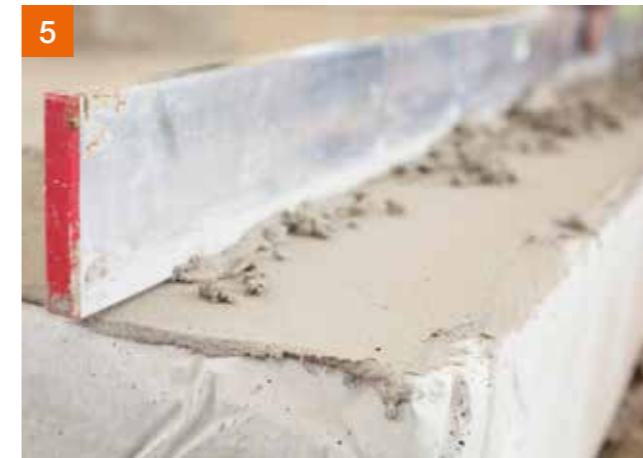
5 Nach ca. 60 Minuten die Fläche egalisieren, z. B. durch Abkratzen mit einer Alulatte (Bild)
