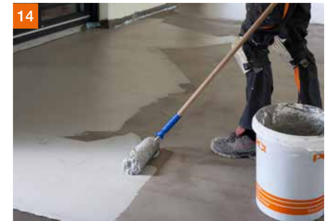
Nach dem Austrocknen der ersten Schicht wird die zweite Schicht bis zu einer Mindestrockenschichtdicke von 2,0 mm aufgebracht (z. B. rollen, streichen oder spachteln)
