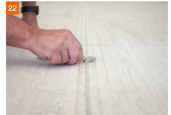
22 Glätten der frisch eingebrachten Bewegungsfuge
