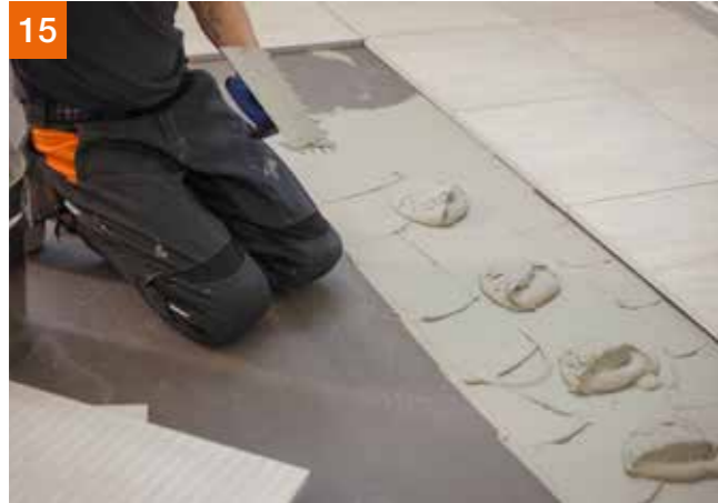
15 Aufbringen der Kontaktschicht mit PCI Flexmörtel® S2
