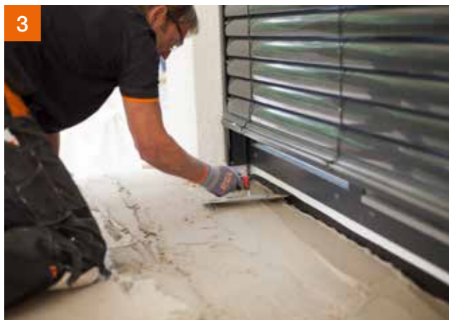
3 Untergrund ausbessern bzw. ausreichendes Gefälle 1,5 – 2,0 % mit PCI Pericret® erstellen
