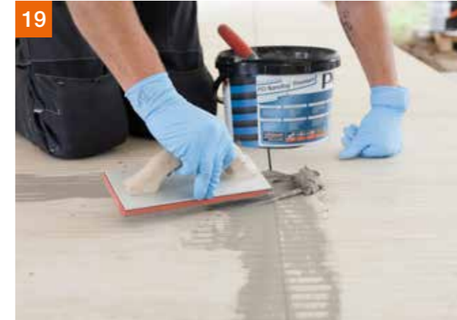
19 Einfugen mit PCI Nanofug® Premium
