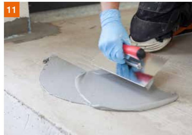
Aufbringen der Kontaktschicht (Kratzspachtelung oder Schlämmen/Rollen mit verdünntem Material)
