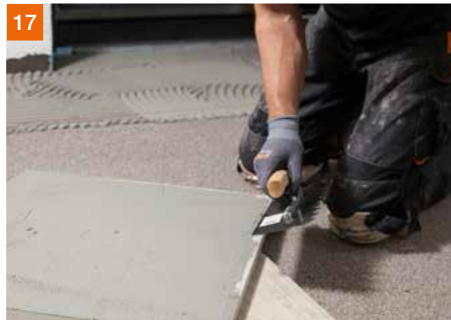
17 Aufbringen der Kratzspachtelung auf die Fliese
