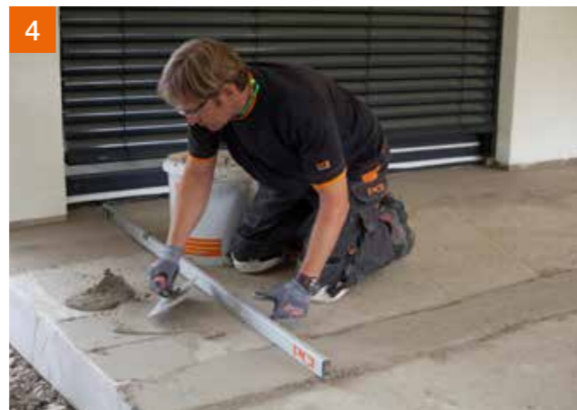
4 Nach Herstellen der Gefällelehren kann die gesamte Fläche abspachtelt werden.
