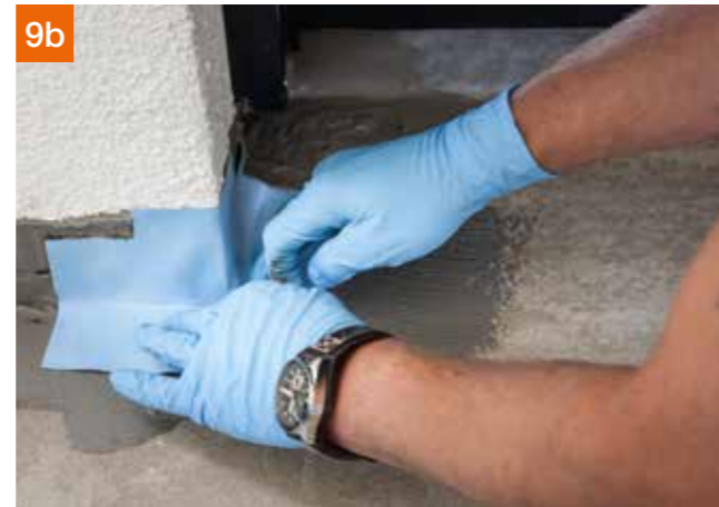
Einbetten der Dichtecken PCI Pecitape® 90 I/A in PCI Seccoral® 2K Rapid
